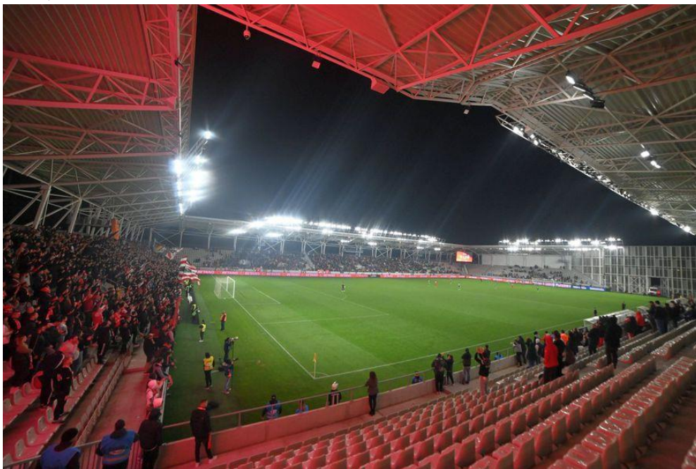
Figura 131 Stadionul "Arcul de Triumf,, Sursa www.gsp.ro
